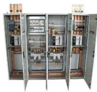
Распределительные щиты (АВР, ВРУ, ГРЩ)
