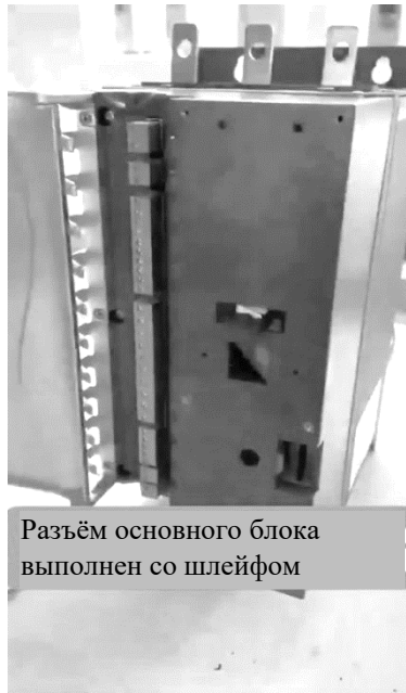
Панель управления можно смонтировать на пень ЩУ. Подключение выполняется кабелем 8Р
